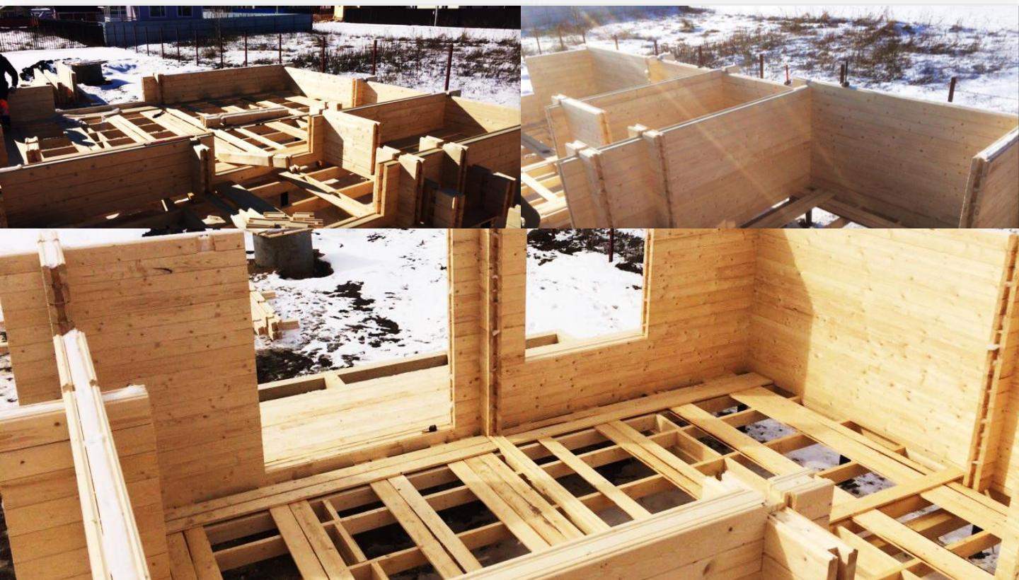
Далее виден процесс сборки с разных ракурсов. Идет **возвведение второго этажа вместе с фронтонами дома**. Все проемы под окна и двери закладываются в чертежи и получаются автоматически при сборке конструктора:
