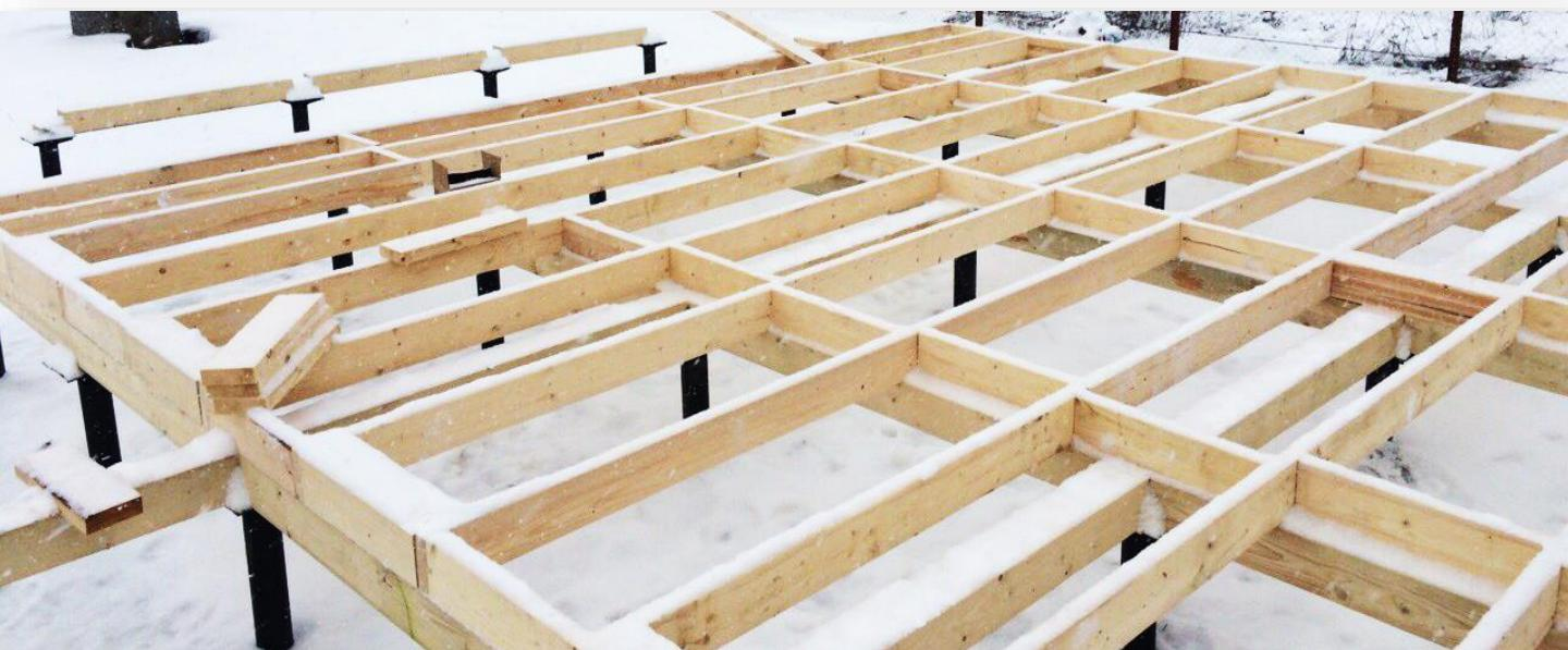
На следующих фото идет **сборка первого этажа дома**. Опытная бригада может провести эту операцию за 1 день, в зависимости от размера и сложности конструкции. Данный проект имеет размер 12,5 x 7 метров общей площадью 140 метров квадратных.
